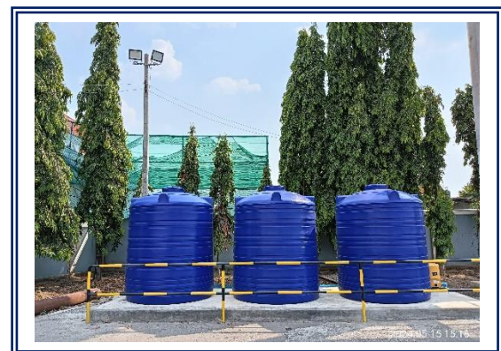
รูปที่ 3-39 ถังสำรองน้ำใช้ปริมาณอย่างน้อย 15 ลูกบาศก์เมตร
