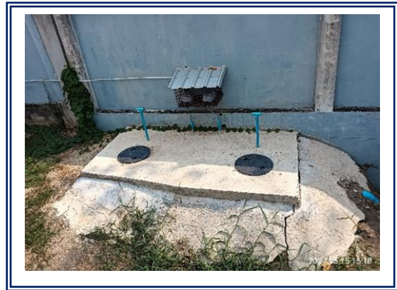
รูปที่ 3-14 ถังบำบัดน้ำเสียสำเร็จรูปชนิดเติมอากาศ แบบ Aerobic Fixed Film
