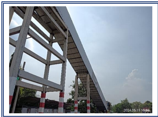
รูปที่ 3-9 อุปกรณ์ปิดได้สายพานลำเลียงสังเกตการณ์ที่ 1 ไปยังหอคอยสังเกตการณ์ที่ 2
