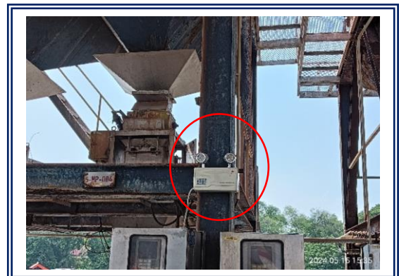
รูปที่ 3-53 ระบบไฟฉุกเฉินแบบหลอด LED บริเวณท่า เทียบเรือ
